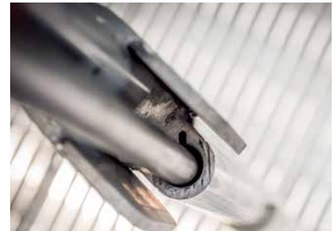
Die inneren Tore haben ein rundes Scharnierprofil und abgerundete Seiten, um Verletzungen zu vermeiden. Der Raum für den Stahl-Sicherungsbolzen hat einen Blindablauf, um auch bei Frost einen guten Betrieb zu gewährleisten.
