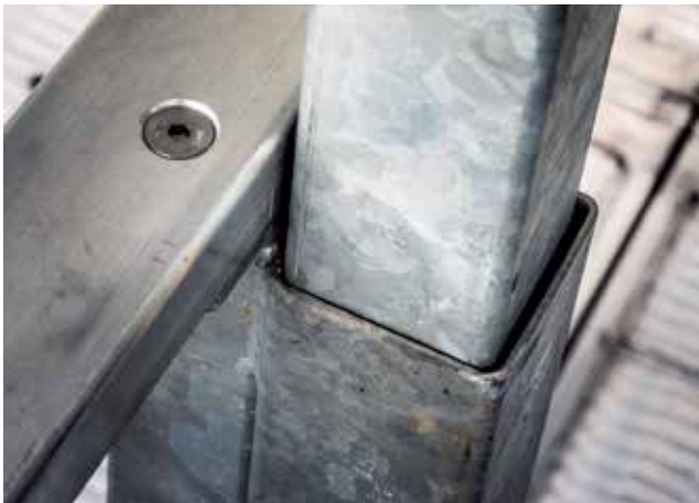
Detail ondersteuning paraplu kap. Staander met verborgen hydraulische cilinder. Uniek Berdex ontwerp met nauwelijks beweegbare delen.
